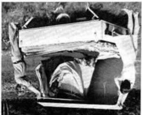
Bild 4 Erste Aufbauphase: Aufklappen des Deckes
